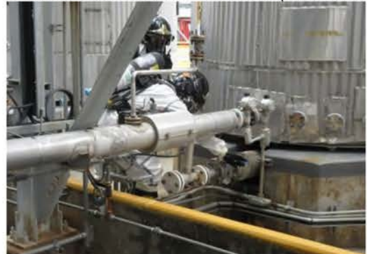
4. ERT เข้าทำการตัดแยกระบบเพื่อหยุดการรั่วไหล
